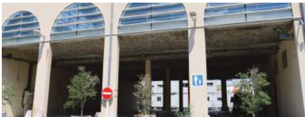
Création d'une salle de boxe au rez-de-chaussée du gymnase Bourcier.
