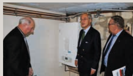
Visite de chantier par les élus
