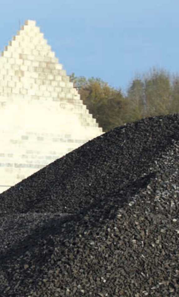
Le programme du Maubon en cours de construction
