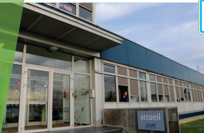
Le bâtiment bientôt rénové au Parc technologique
