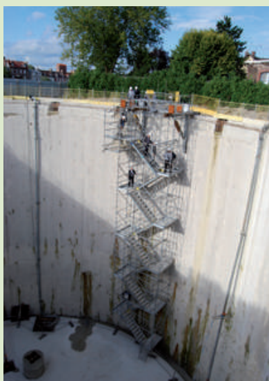
> Le bassin d'orages rue de l'Oise durant sa construction
