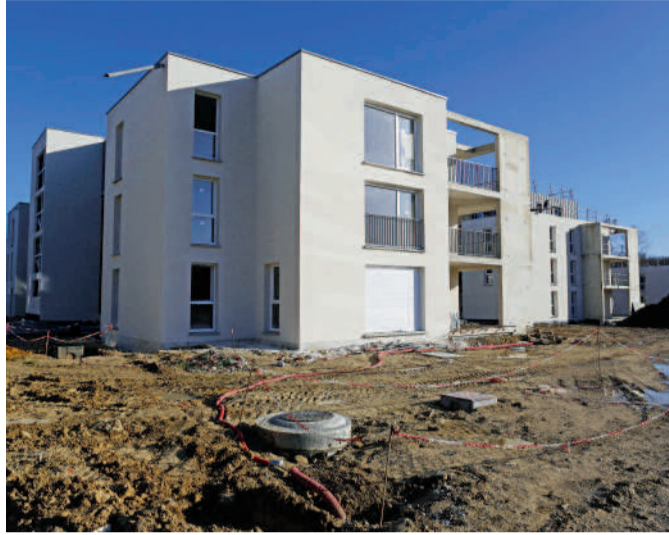
Camp des Sablons, les premières résidences sortent de terre. Ici, le Clos de la forêt, ensemble de 63 logements réalisé par l'OPAC de l'Oise, fait partie des 500 logements qui seront édifiés sur le site.
