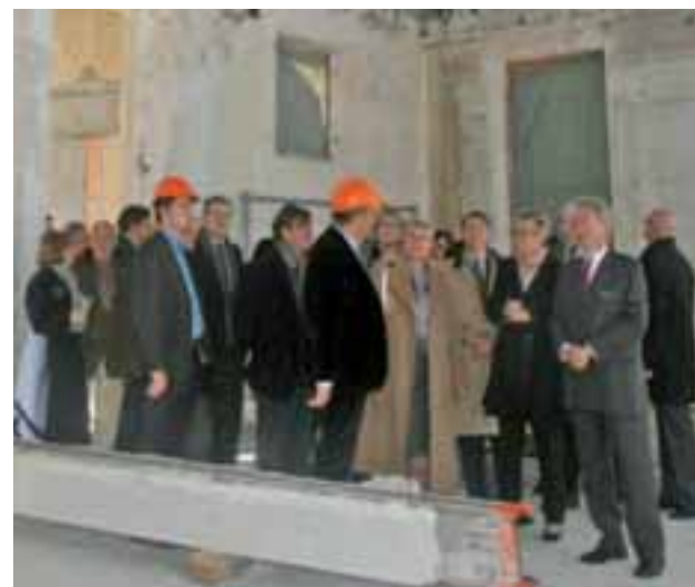
Les travaux de rénovation de l'ancien hôpital Saint-Joseph sont lancés.
