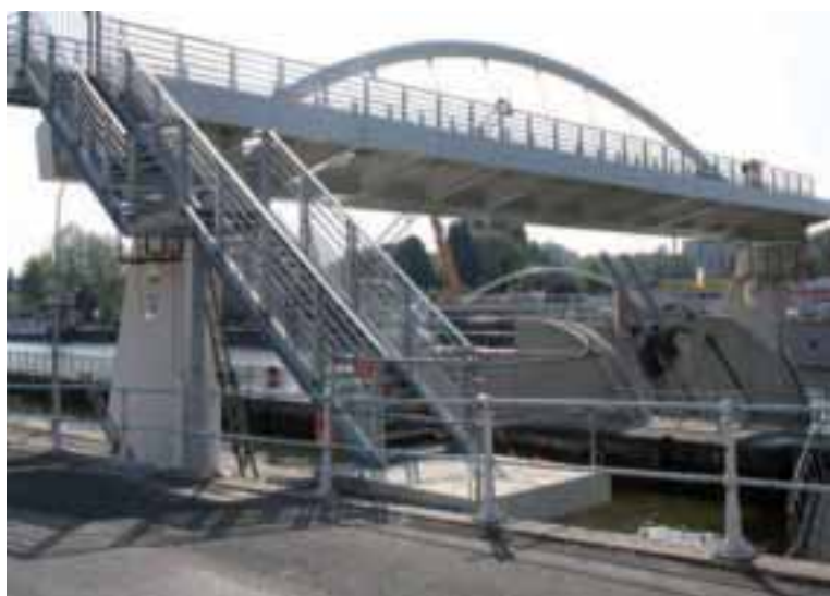
Le nouveau barrage sur l'Oise, entre Compiègne et Venette.
