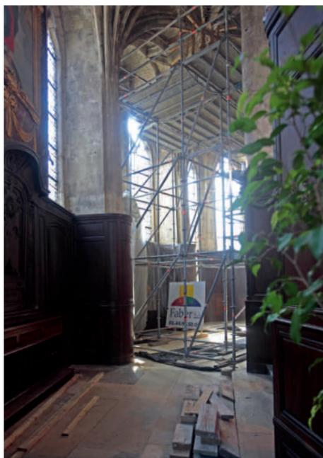
D'un montant de 350 000 euros, ils seront destinés à mettre en sécurité le chœur de l'édifice avec une reprise des pierres dans les parties élevées, des travaux de rejointoiement et d'étanchéité avec des interventions sur la couverture et la charpente. Ces aménagements sont en partie à la charge de la Ville qui est propriétaire de l'édifice, classé monument historique.
