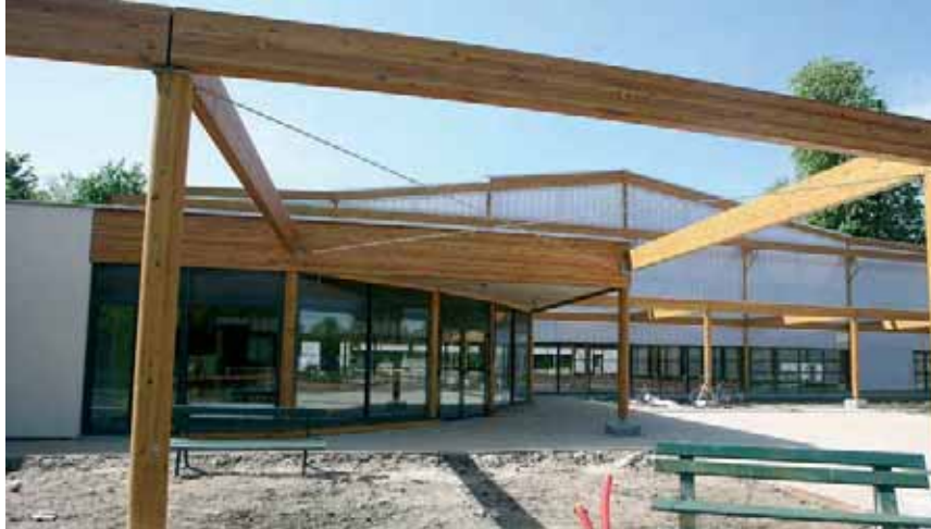
Les nouvelles installations du tennis Pompadour seront inaugurées le samedi 14 juin.
