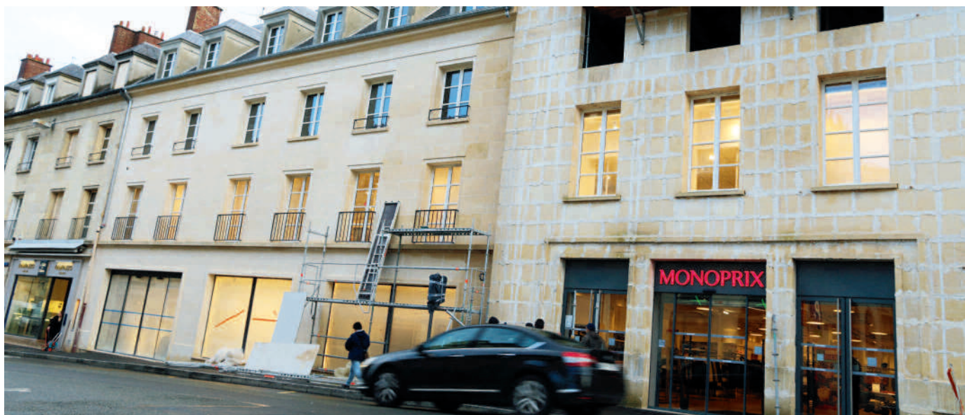
La rue Solferino en cours d'aménagement.
