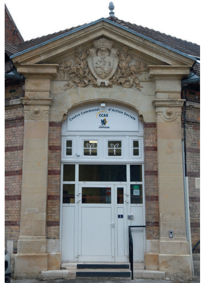
Après douze mois de travaux, le Centre d'Hébergement et de Réinsertion Sociale situé 6 rue Pasteur est totalement rénové.
