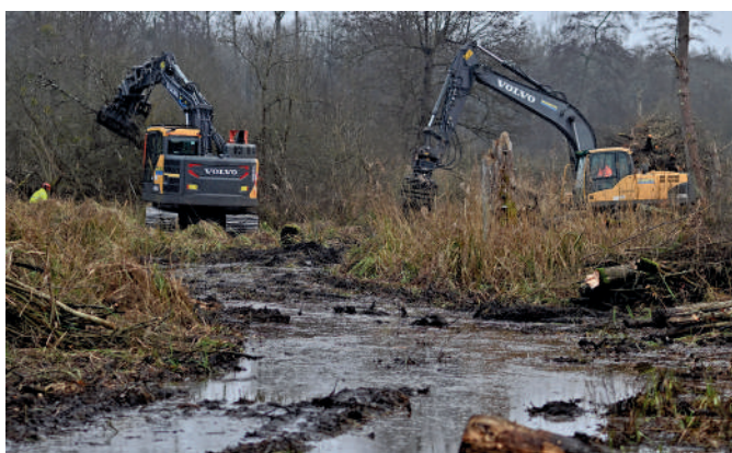
Un important chantier de restauration a été mené dans le Grand Marais.
