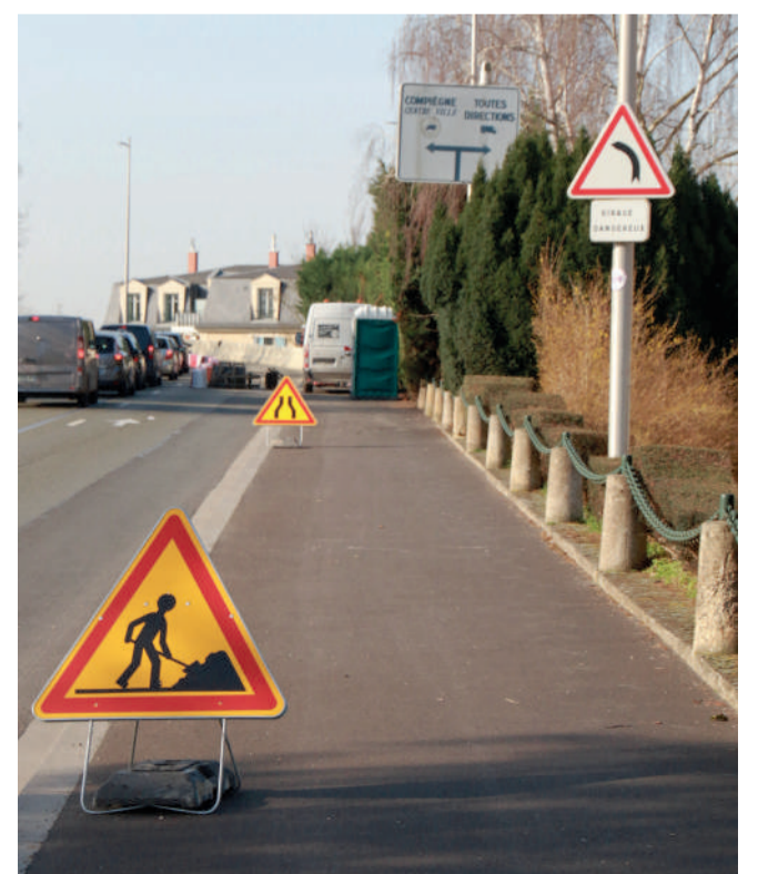
Après plusieurs mois de travaux, la piste cyclable permettant le franchissement des voies ferrées sera mise en service ce mois de mai.
