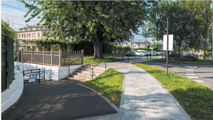
Côté Margny-lès-Compiègne, l'accès au souterrain a été réaménagé avec la création d'un escalier amenant vers le parking
